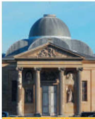
La Chapelle Hoche, très délabrée, sera restaurée.
