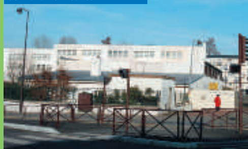
La reconstruction du gymnase Richard Mique est en cours.
